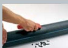
Juste avant de placer la selle sur le conduit, nettoyer la surface grattée en utilisant du papier doux résistant trempé dans un détergent adapté pour retirer toutes les traces de poussière, d'huile, etc.
