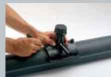
Quitar la superficie oxidada del tubo, raspando con una herramienta adecuada.
